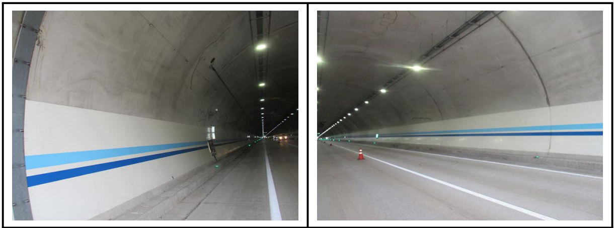
【사진 6.3.3】 라이닝 측벽부 전경
