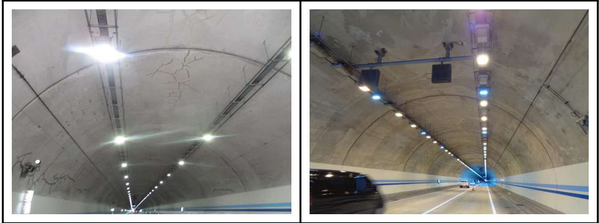
【사진 6.3.1】 라이닝 천단부 전경
