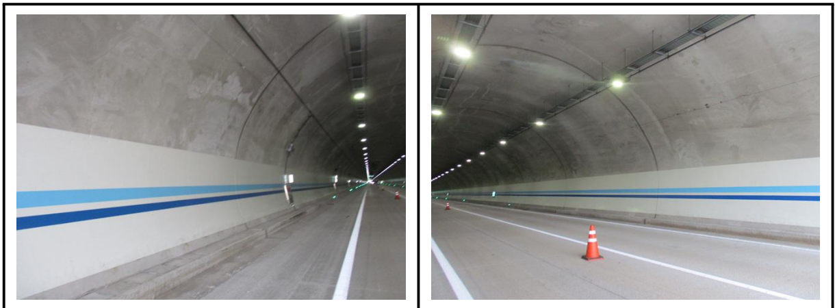
【사진 6.3.17】 라이닝 측벽부 전경
