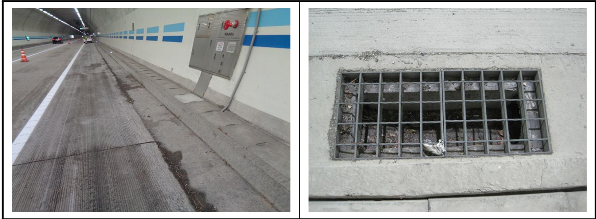
【사진 6.3.23】 공동구 및 배수시설 전경
