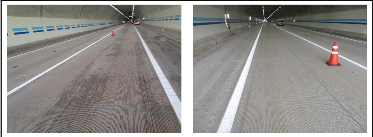
【사진 6.3.25】 포장부 전경
