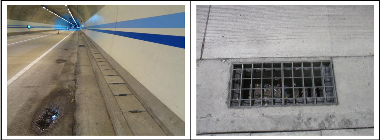
【사진 6.3.9】 공동구 및 배수시설 전경
